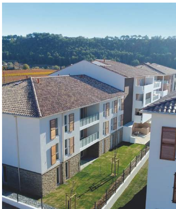
© Var Habitat - Empreinte Architecte
