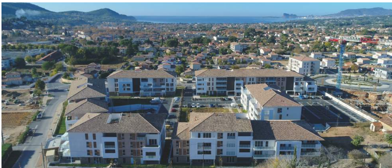
© Var Habitat - Empreinte Architecte
