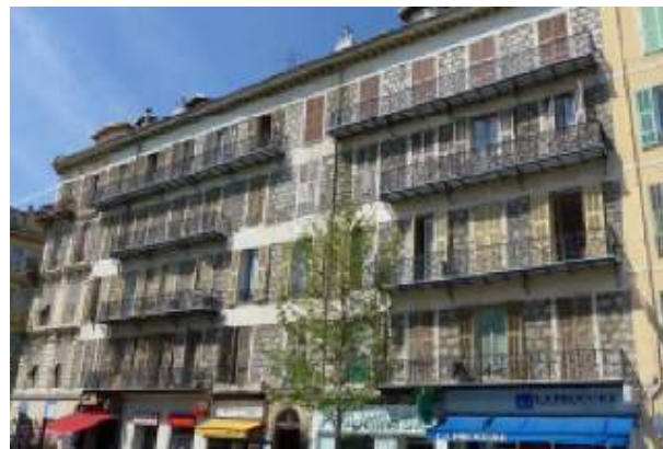
© Metropole Nice Côte d'Azur / Ville de Nice (façade 10 rue de Suisse)
