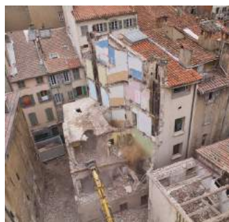
Déconstruction dans le centre-ville
